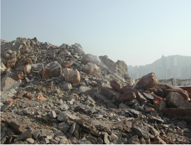
來自拆卸工程的一般惰性拆建物料
