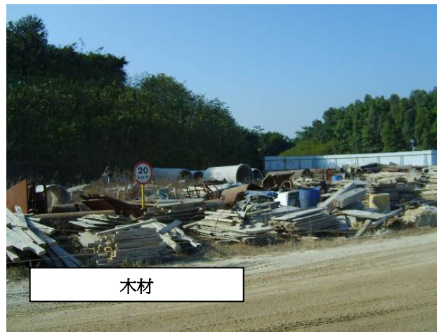
物料分類供再用或循環再造。小心拆卸可以確保高水平的物料回收
