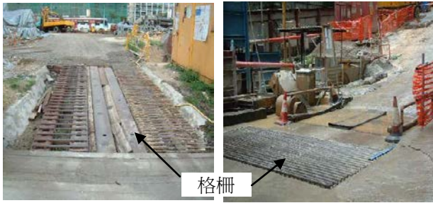
安裝格柵以進一步從車輛卸下沙塵
