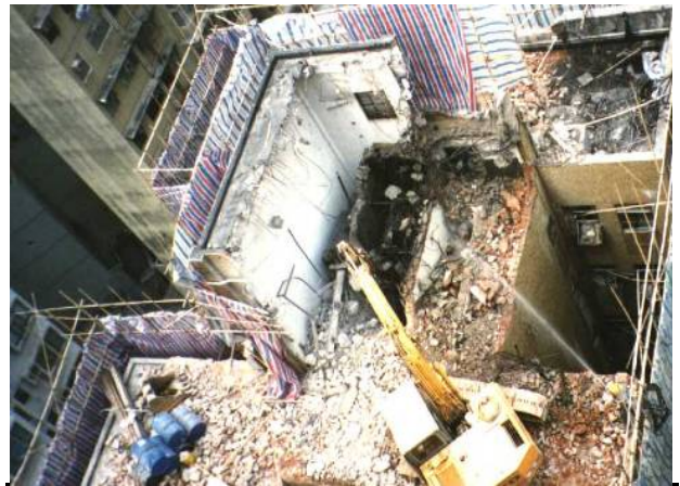
在拆卸工程中噴水
