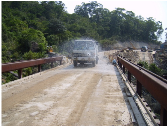
用水噴運輸道路，以阻止塵埃擴散
