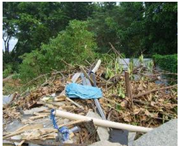
含植被、木材和塑料的拆建廢料
