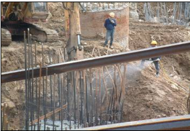
應定期噴灑水，避免揚塵。可考慮自動噴灑水系統應，以減少所需的人力
