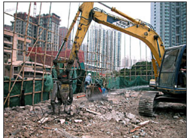
拆卸工程的液壓式混凝土破碎機
