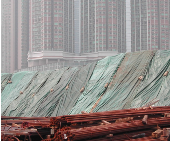
塵土飛揚的堆存物料被蓋好，避免風吹塵埃排放
