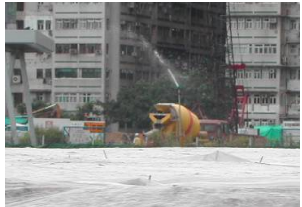
自動噴水系統是在大型建築地盤一種有效的抑塵緩解措施
