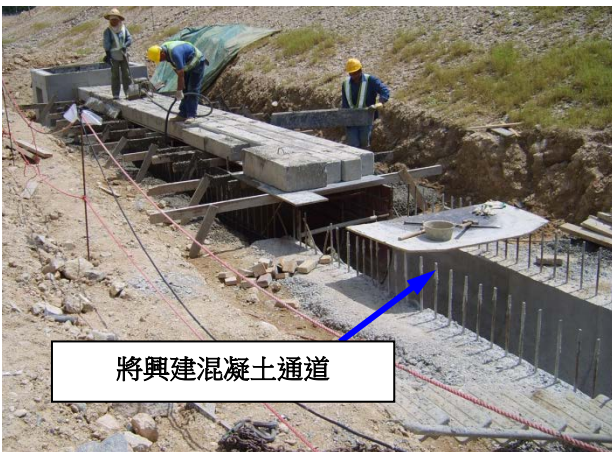
在混凝土工程使用金屬模具
