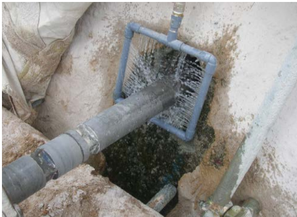
塵盾土釘鑽機
