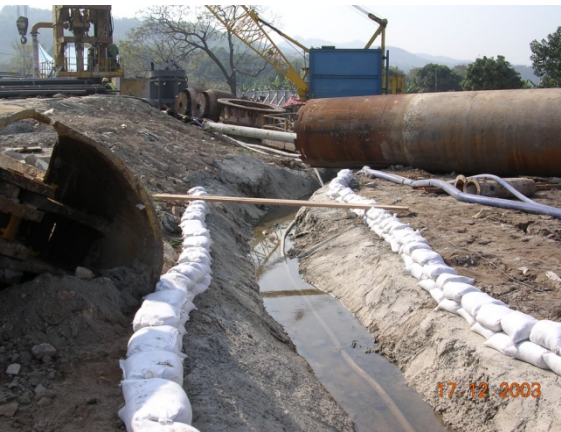
豎立沙包屏障保護臨時排水通道
