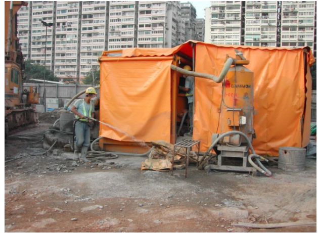
進行塵土飛揚的活動時，應提供密封罩及除塵設備
