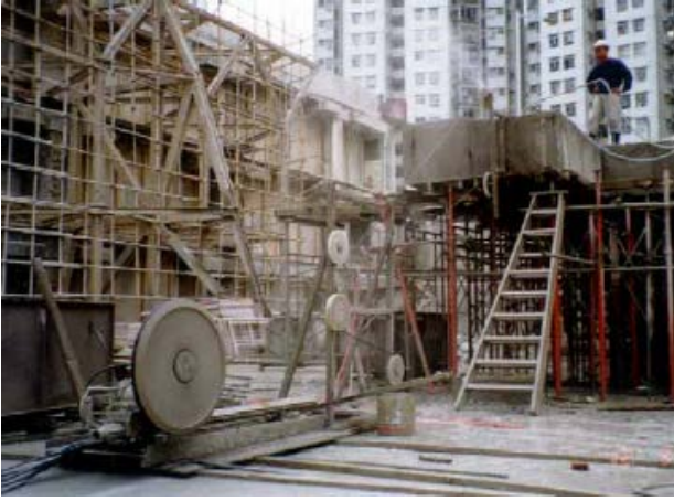
繩鋸混凝土切割工程 照片摘錄自環保署網頁
