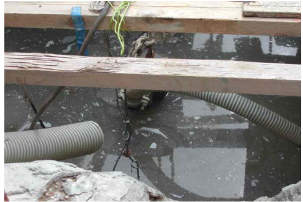
地下水池用作接收罐池
