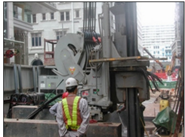
樁板材打樁工程的超寧靜打 照片摘錄自環保署網頁
