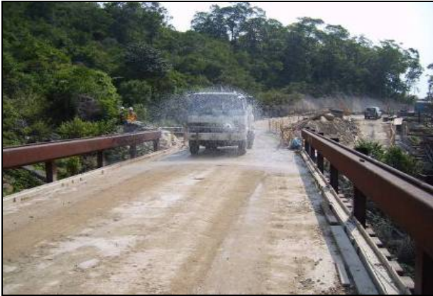
可使用水罐車在大型工地噴水，土木工程建築尤其適用
