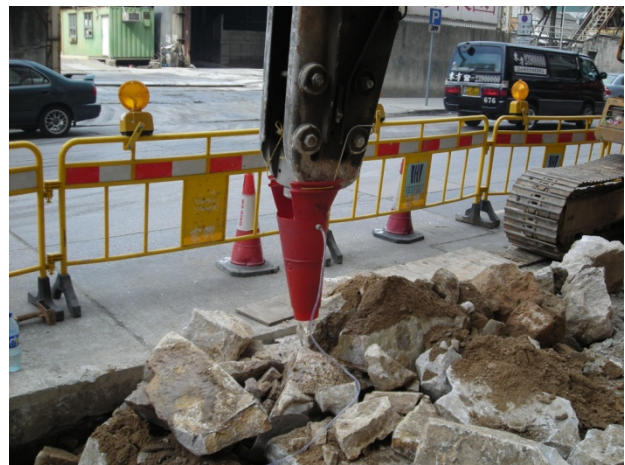
安裝於反鏟挖土機的噴水漏斗
