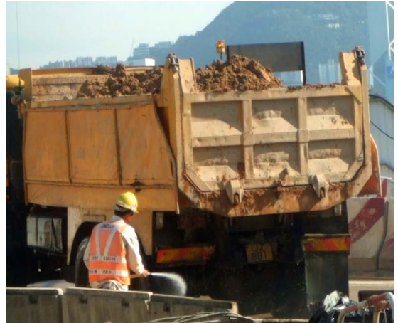
負載物品比車輛側及尾板更高，導致在運輸過程中排放塵埃
