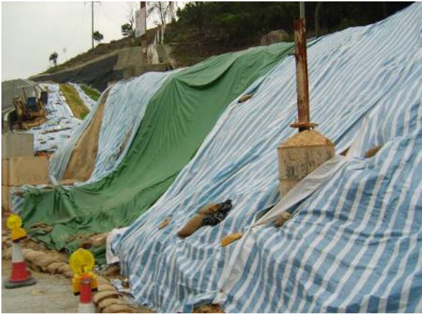
遮蓋用於建築工地能盡量減少粉塵排放，特別是對附近敏感受體的位置
