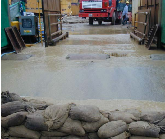
提供堤壘，防止廢水從地盤徑流
