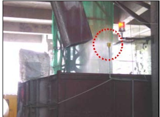
在廢物排放點的細水噴霧用來抑制塵埃 （圖片由環保署網頁中提取）
