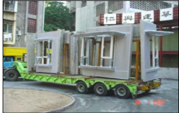
預製單位的樓宇外牆
