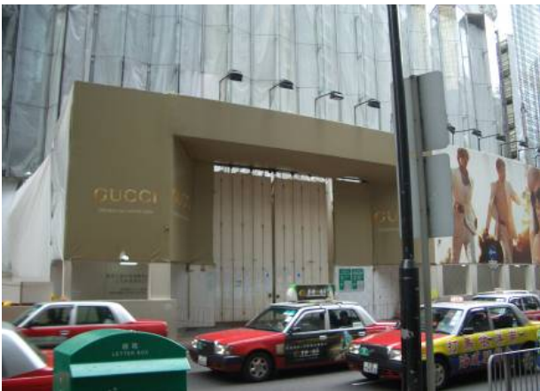
樓宇建築工程以不透水物料作為防塵網
