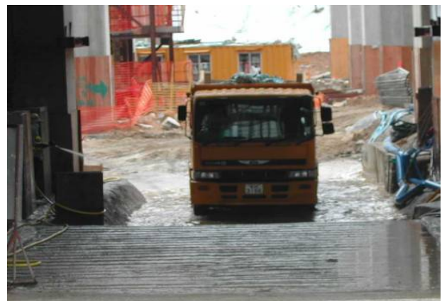
自動噴水系統是在大型建築地盤一種有效的抑塵緩解措施
