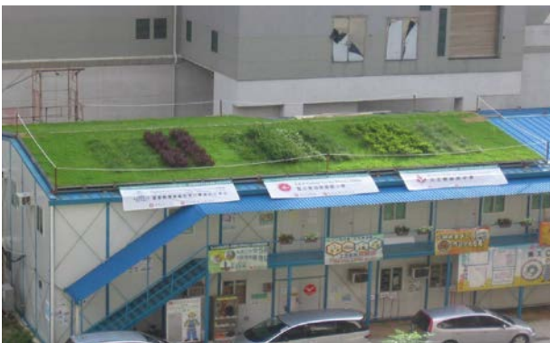
安裝在地盤辦公室屋頂的綠色覆蓋層
