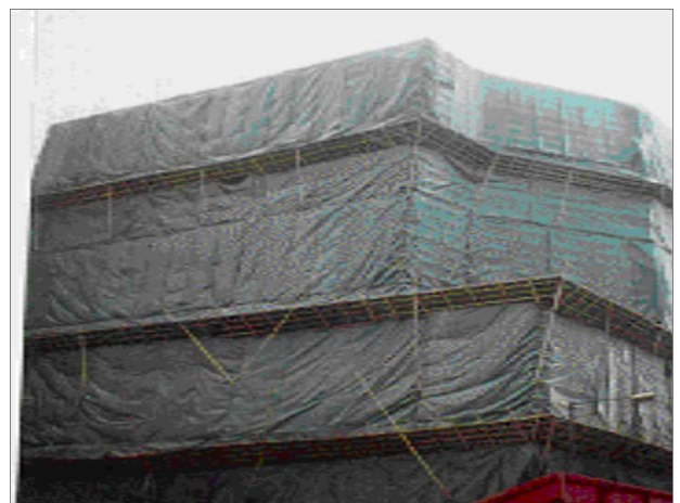
在拆卸工程中以不透水物料作為防塵網
