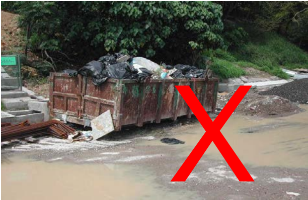
需要排空混合廢物箕斗 - 確保有一個最佳實踐的監測制度
