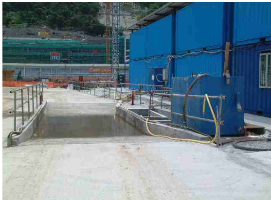
在工地出口設置車輪清洗設施，從車輛去除沙/塵
