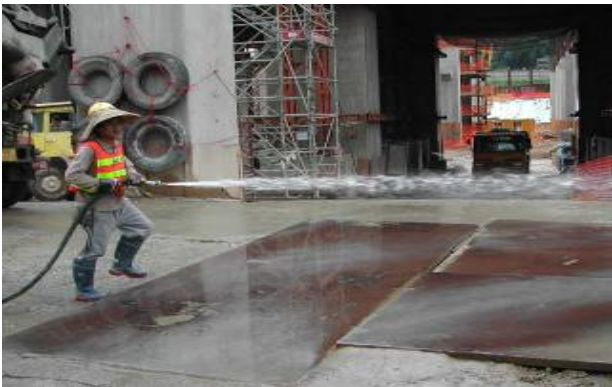
一些建築工地用回收/處理過的水進行清洗
