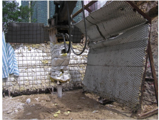
破碎工程用的隔音屏障
