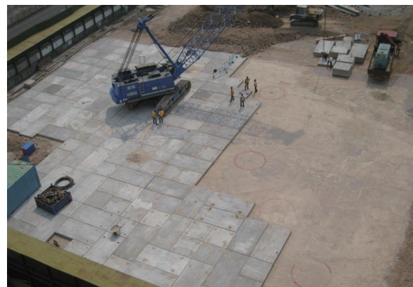
在地盤鋪設混凝土預製板
