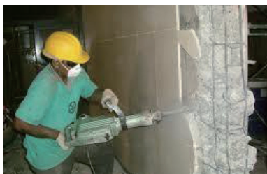
拆卸混凝土及瓷片
