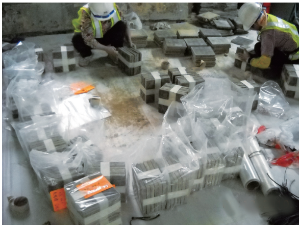
建造工程常見的水泥磚
