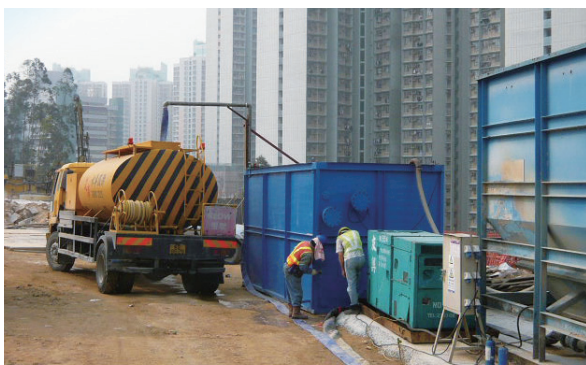
水車裝載處理後的污水穿梭地盤不同地點，為液壓破碎機的灑水系統重新注水
