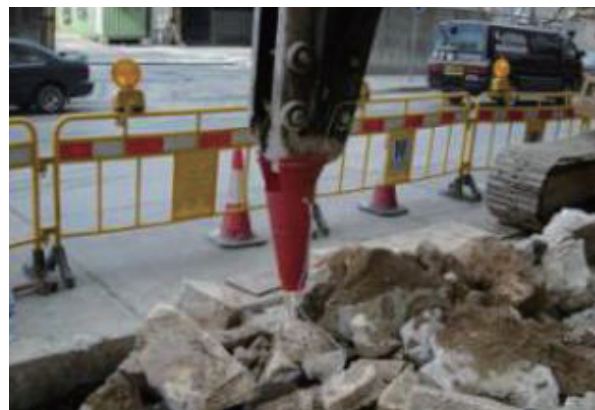
安裝於反鏟挖土機的灑水漏斗
