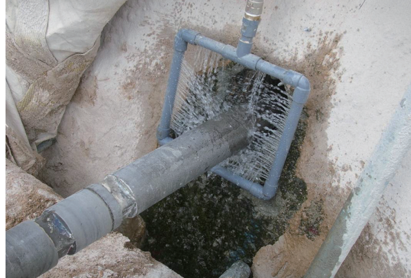
控制塵埃的灑水系統
