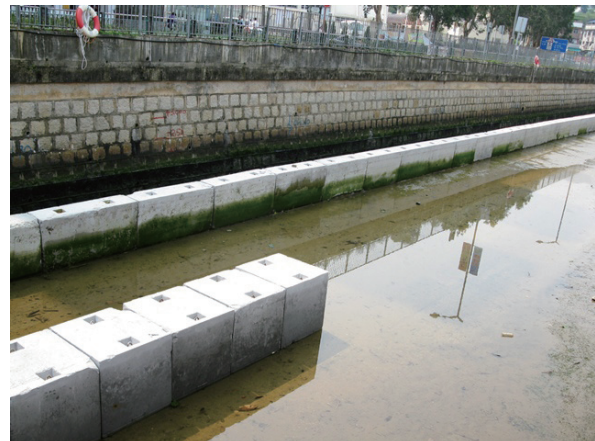
把混凝土磚用於明渠分流
