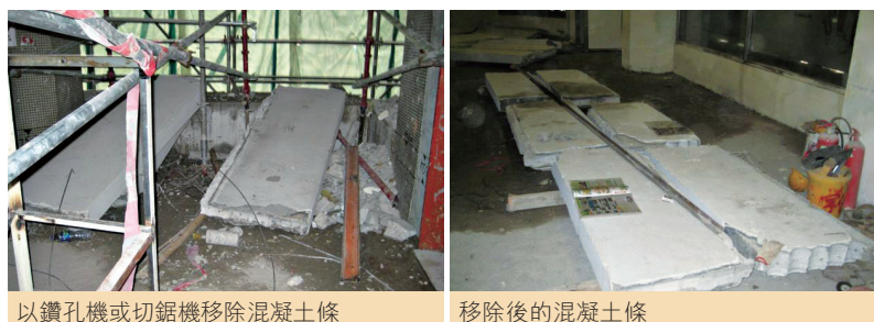
以鑽孔機或切鋸機移除混凝土條
