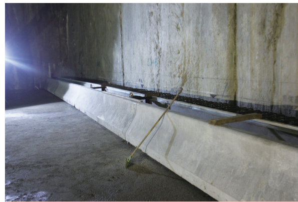
送到工地的預製路邊防撞欄
